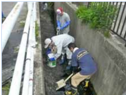
土のう袋へドロを詰める作業
